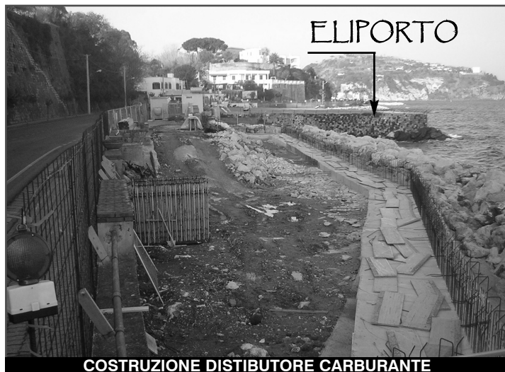
COSTRUZIONE DISTRIBUTORE CARBURANTE
